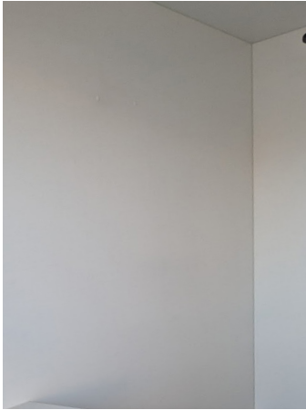
Wand afwerking Wit Mat
